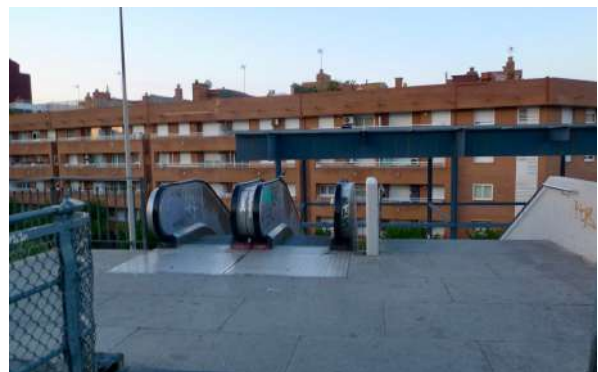
Fotos que muestran más detalles del puente que conecta Santa Eulàlia con Collblanc
